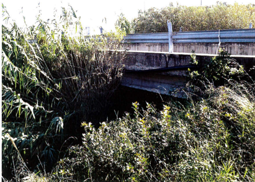
Foto n° 3: Alveo Tronco Critico ZI_B1, attraversamento in corrispondenza della sez. 40 visto da monte.
