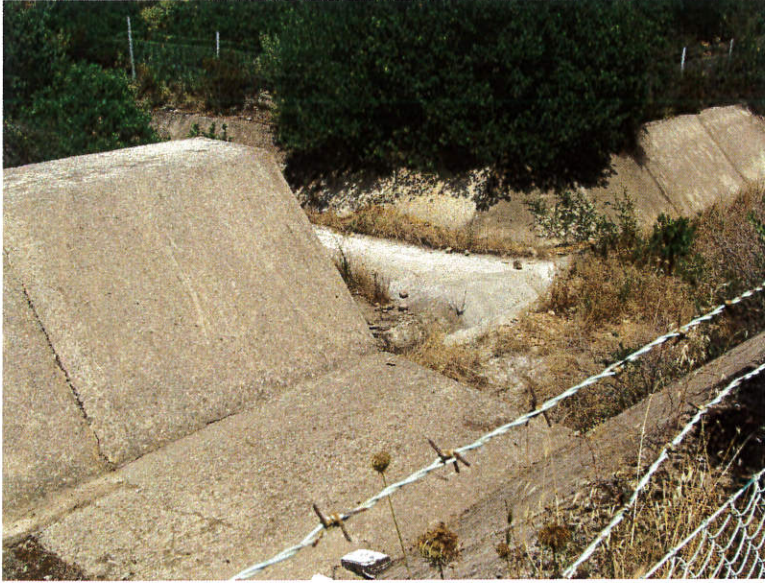
Foto n° 31: Alveo Tronco Critico ZI_B3.1.2, vista del salto di fondo alla sezione 39
