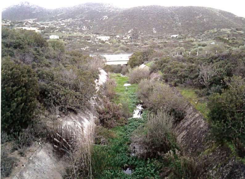
Foto n° 39: Tronco Critico ZI_B3.1.2, vista dell'attraversamento in corrispondenza della sezione 7 dall'attraversamento in corrispondenza della sezione 12.
