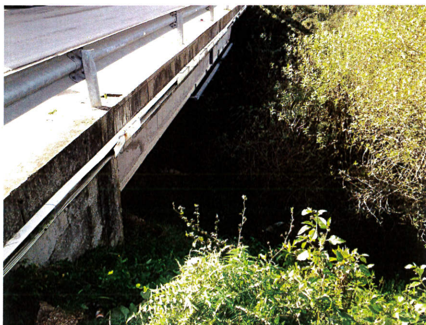
Foto n° 2: Alveo Tronco Critico ZI_B1, attraversamento in corrispondenza della sez. 45 (vista da monte).
