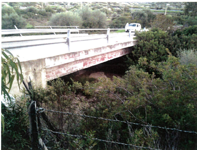
Foto n° 36: Alveo Tronco Critico ZI_B3.1.2, vista dell'attraversamento in corrispondenza della sezione 25
