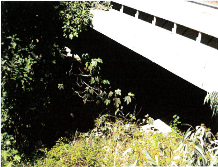
Foto n° 8: Alveo Tronco Critico ZI_B1, attraversamento in corrispondenza della sez. 11.
