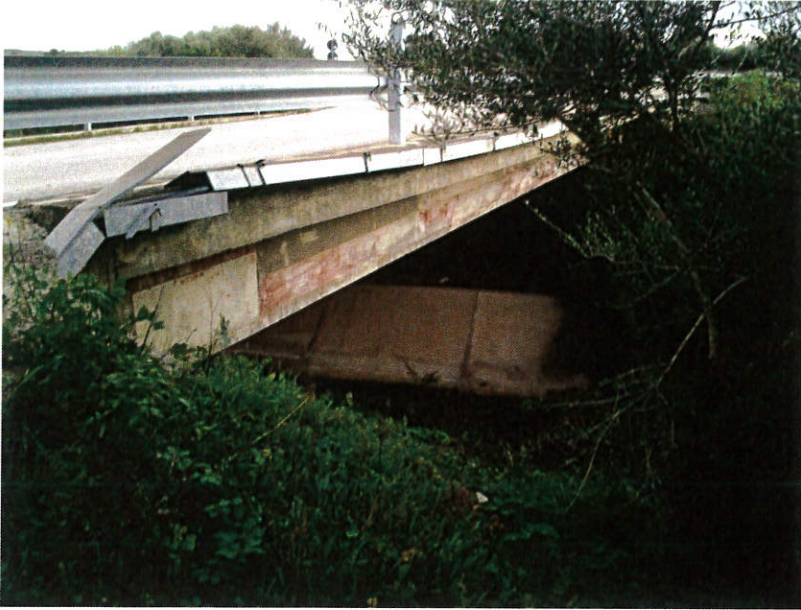
Foto n° 38: Alveo Tronco Critico ZI_B3.1.2, vista dell'attraversamento alla sezione 17
