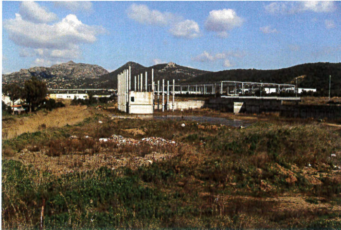
Foto n° 25: Alveo Tronco Critico ZI_B3, vista da valle dell'alveo a monte della sezione 11. E' visibile il cantiere e la struttura dell'edificio in costruzione
