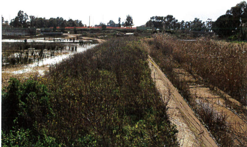
Foto n° 26: Alveo Tronco Critico ZI_B3, vista del tratto a valle della sezione 11.8. E' visibile, a partire da destra, la golen, la sommità spondale, il piano di campagna inalterato e lo sbancamento
