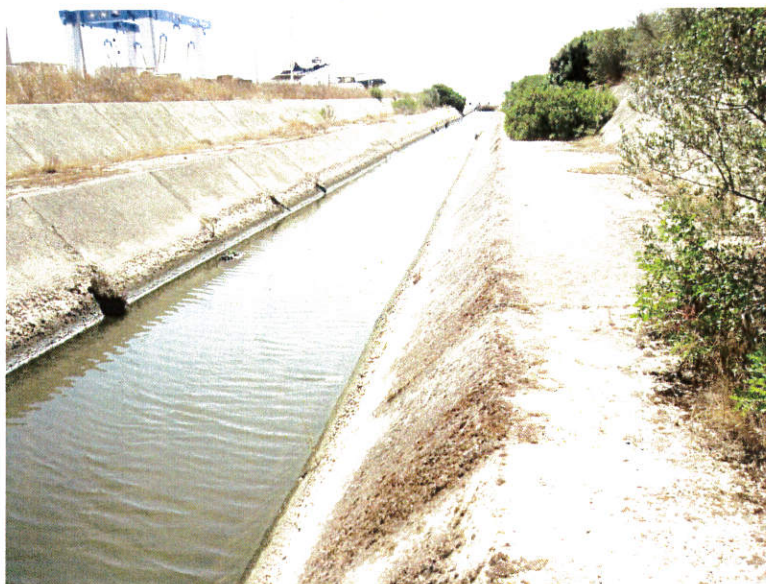
Foto n° 10: Alveo Tronco Critico ZI_B1, vista del tratto terminale del corso d'acqua in corrispondenza dello sbocco a mare.
