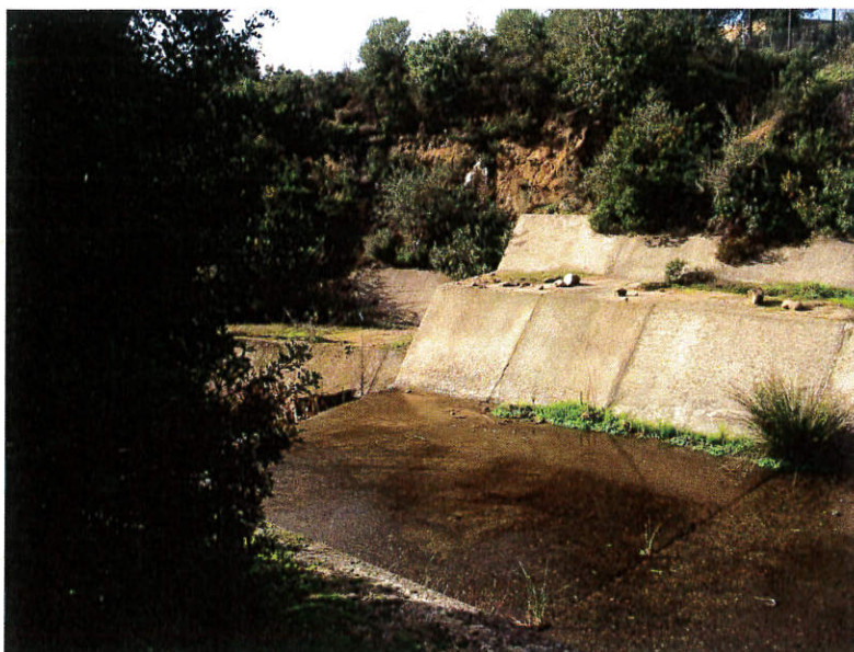
Foto n° 23: Alveo Tronco Critico ZI_B3, vista del salto di fondo in corrispondenza della sezione 27
