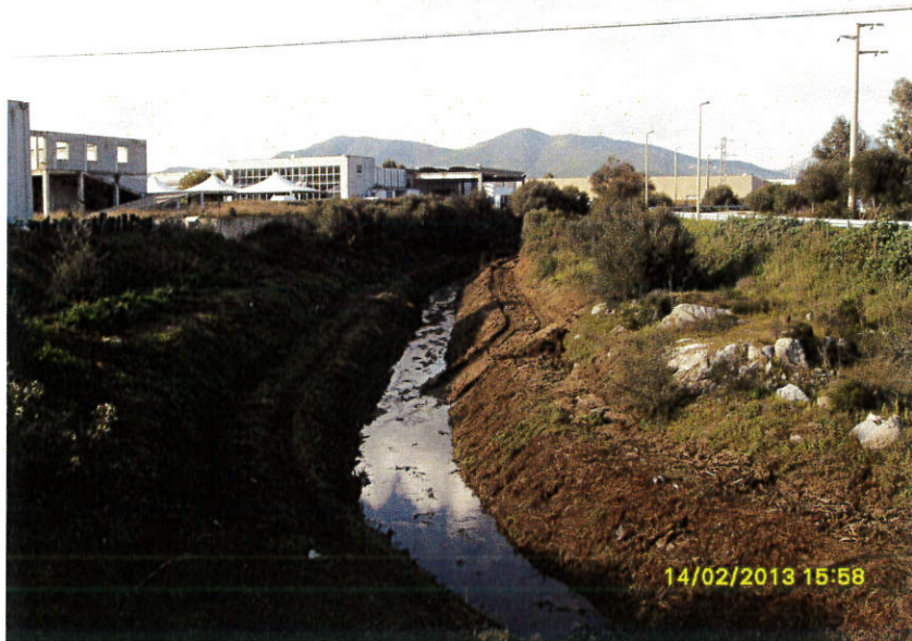
Foto n° 5: Alveo Tronco Critico ZI_B1, tratto in terra a valle della sezione 30 (vista da valle)
