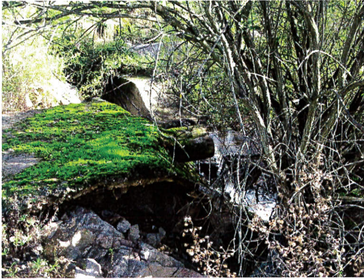
Foto n° 17: Alveo Tronco Critico ZI_B3, vista della sezione 55 ed inizio alveo regolarizzato
