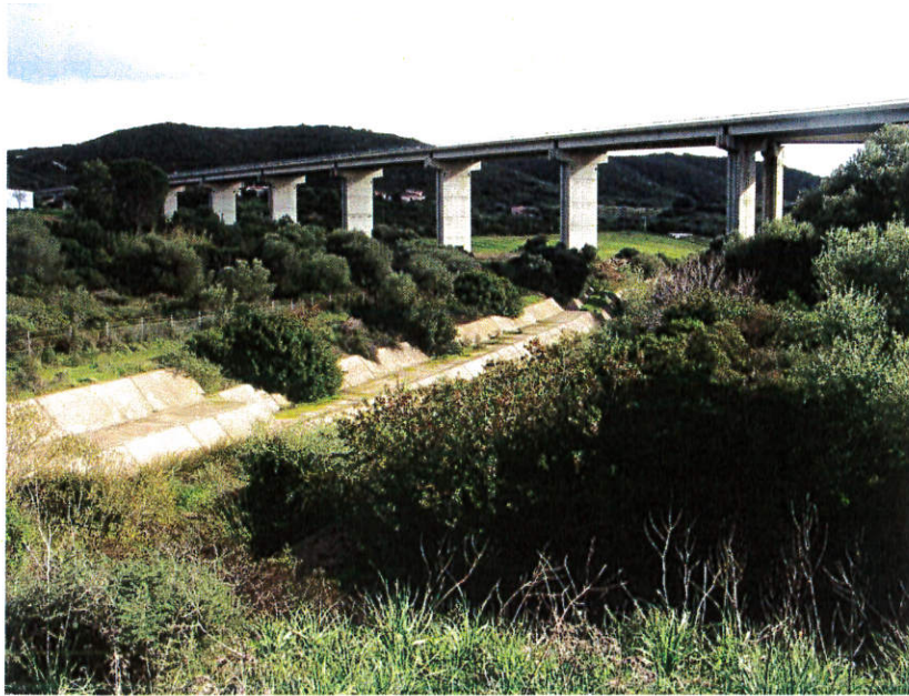
Foto n° 19: Alveo Tronco Critico ZI_B3, vista della tangenziale ovest e del salto di fondo in corrispondenza della sezione 51.
