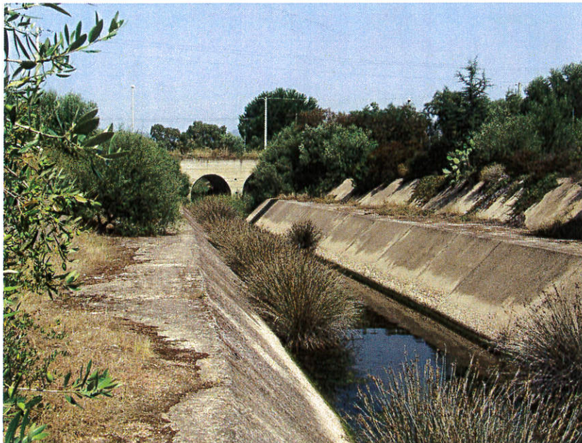
Foto n° 9: Alveo Tronco Critico ZI_B1, vista da valle dell'attraversamento in corrispondenza della sezione 6
