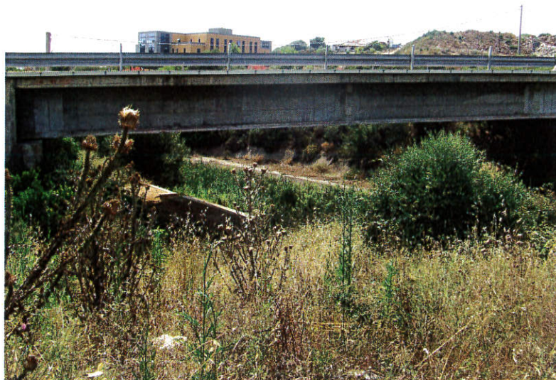
Foto n° 22: Alveo Tronco Critico ZI_B3, vista del manufatto di attraversamento in corrispondenza della sezione 29
