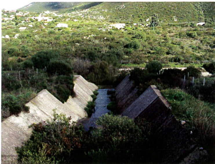
Foto n° 33: Alveo Tronco Critico ZI_B3.1.2, vista del salto di fondo alla sezione 10
