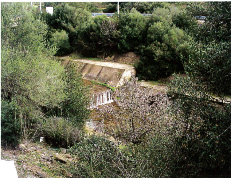
Foto n° 21: Alveo Tronco Critico ZI_B3, vista del salto di fondo alla sezione 35
