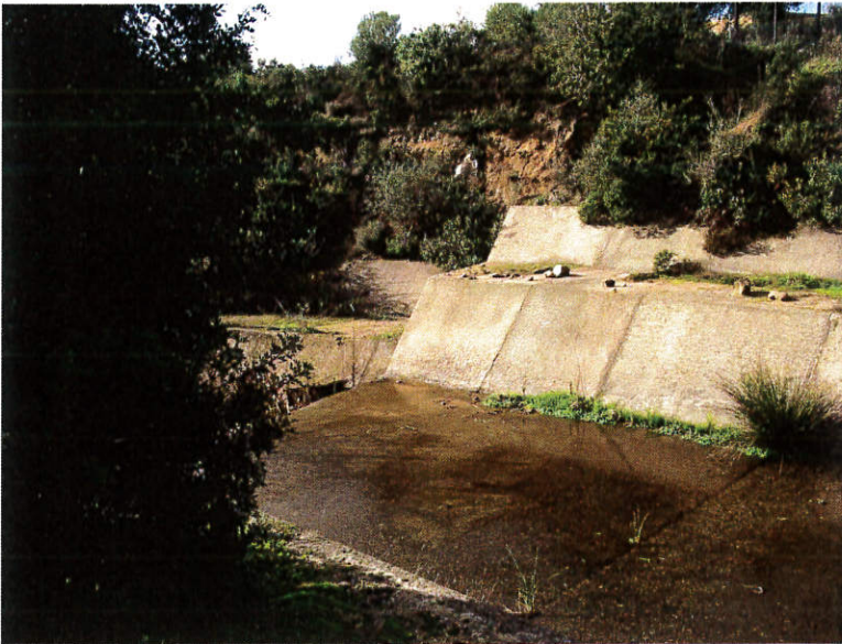
Foto n° 31: Alveo Tronco Critico ZI_B3.1.2, vista del salto di fondo alla sezione 39
