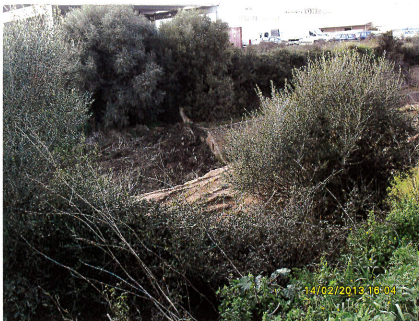
Foto n° 4: Alveo Tronco Critico ZI_B1, particolare del passaggio fra la sezione in calcestruzzo e sezione in terra in corrispondenza del salto alla sez. 30 (vista da valle dalla sponda sinistra ).
