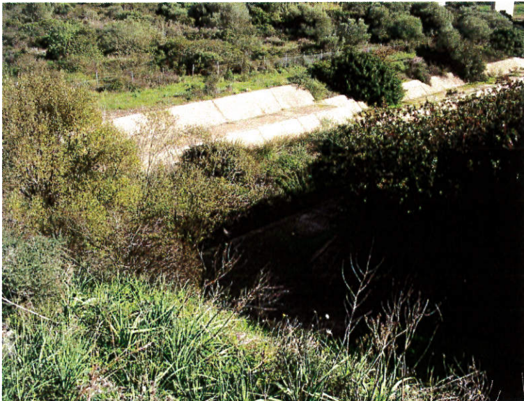
Foto n° 18: Alveo Tronco Critico ZI_B3, vista della confluenza con il canale di guardia
