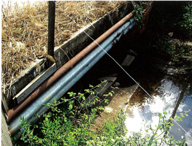
Foto n° 12: Alveo Tronco Critico ZI_B2, attraversamento in corrispondenza della sez. 23.
